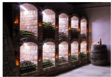
Zabudowa łukowa z cegły
