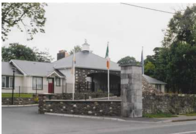
Ilustracja 13. Budynek Westgate Foundation
