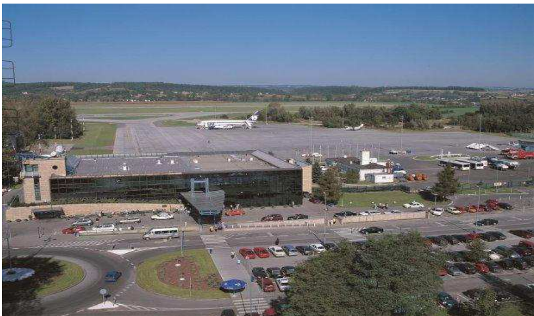
Rys. 11 Port lotniczy po gruntownym remoncie i modernizacji
