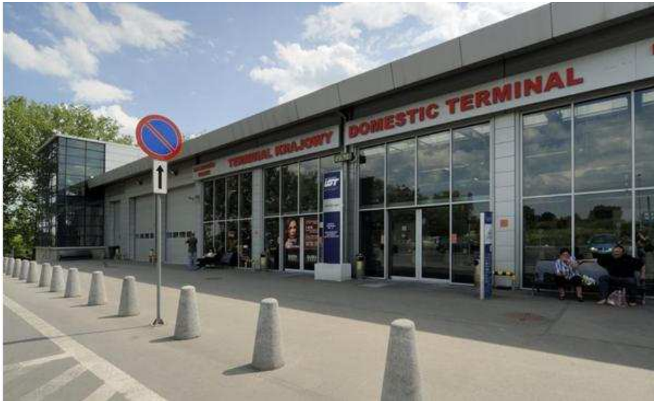
Rys. 14 Terminal krajowy zagospodarowany z budynku warsztatowo – garażowego
