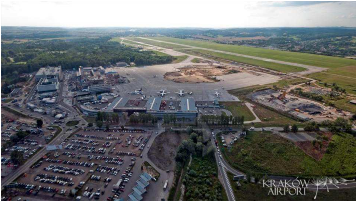
Rys. 23 Kraków Airport podczas rozbudowy – lipiec 2014 roku
