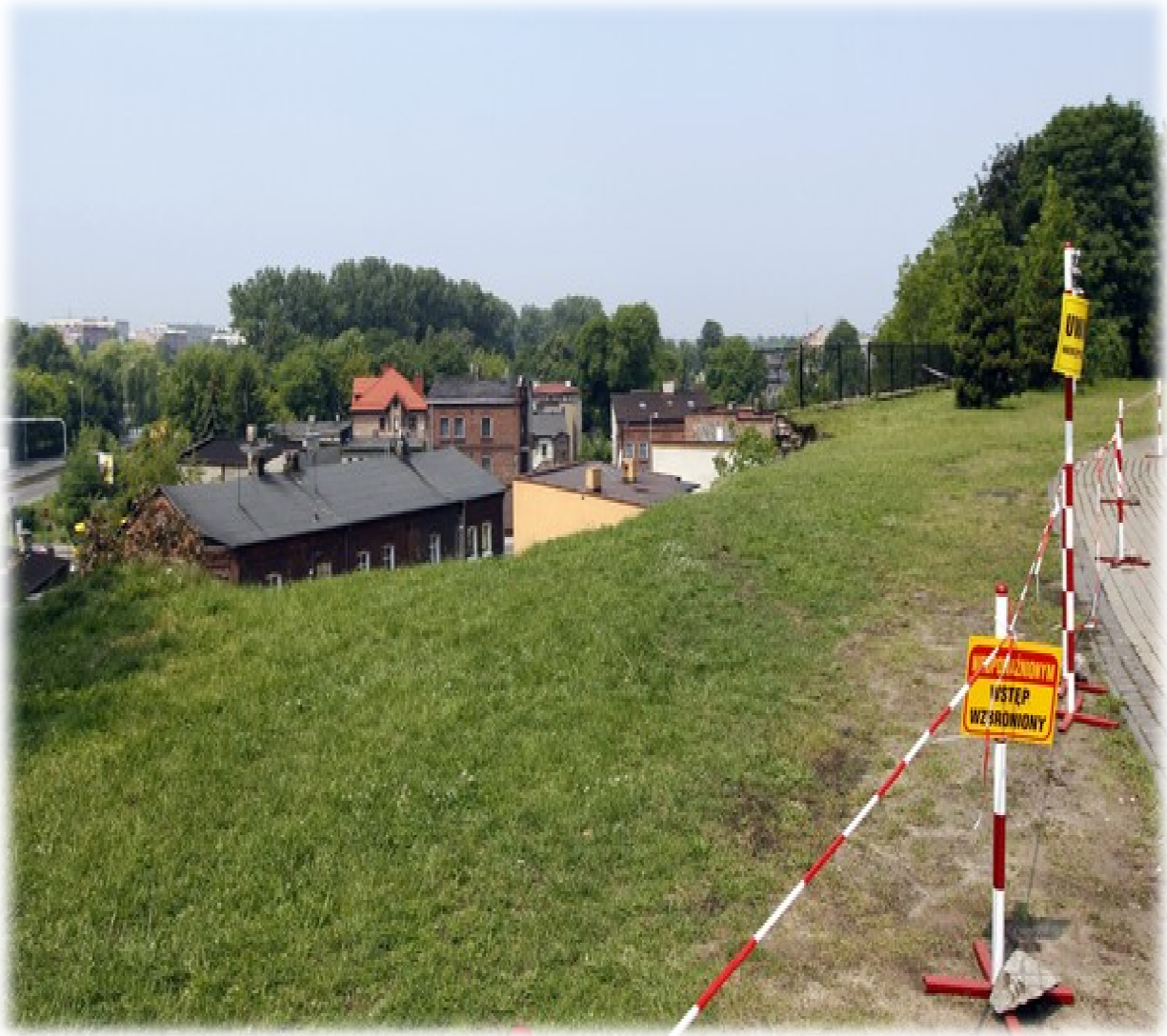
Rys.25. Osuwisko - Popardowa 2.03.2013 - to nie jedyne osuwisko w tej miejscowości (Źródło: http://www.sfora.pl/Grozne-osuwiska-w-Malopolsce-Pekaja-domy-a531270 (16.08.2013 r.)
